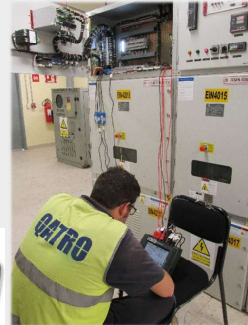
Técnico realizando registros en una acometida de barras de MT
